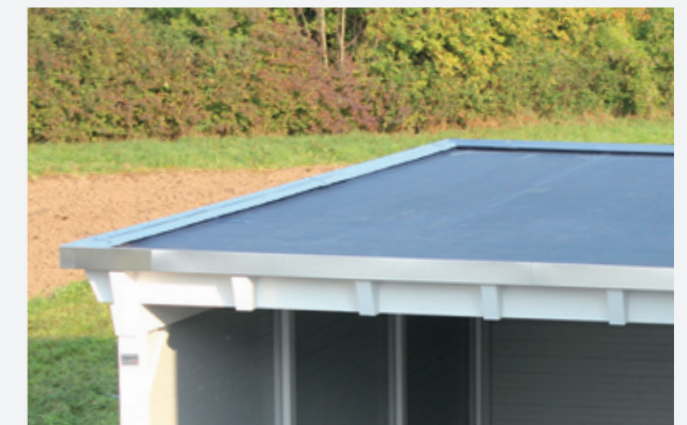
Dach-Wetterseite aus EPDM-Membrane
