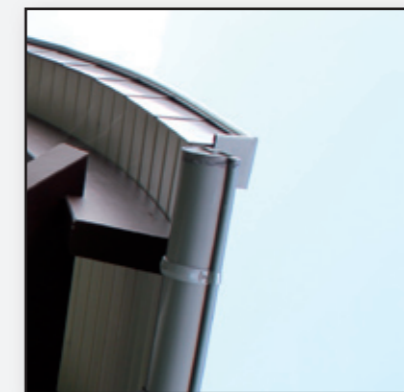
Durchgehende Farbe der Pfosten, auch der Bogenpfosten
