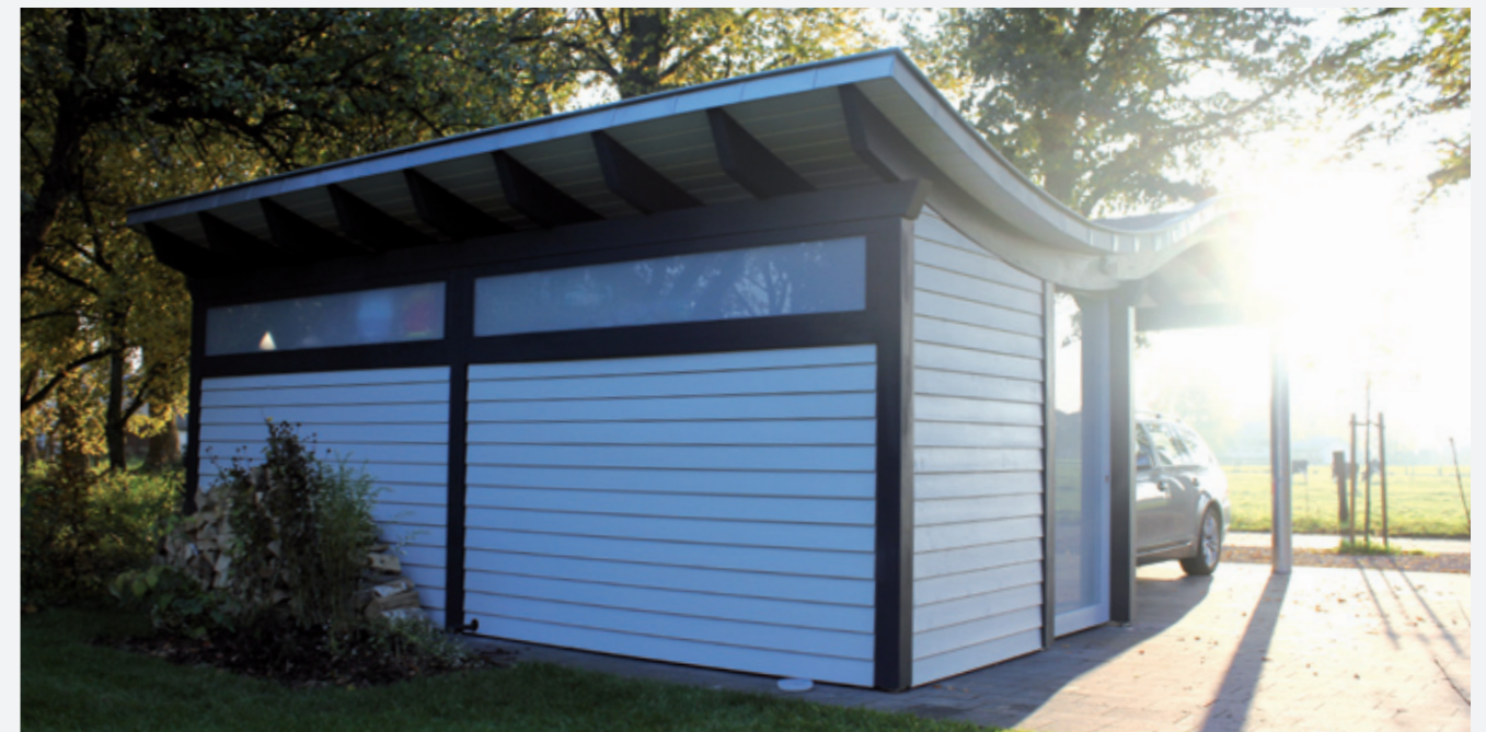
Hochwertige Leimholz-Konstruktion, Spezial-Pfostenanker mit Fenserelementen
