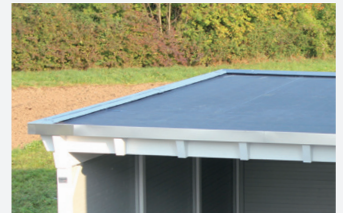
Dach-Wetterseite aus EPDM-Membrane,
