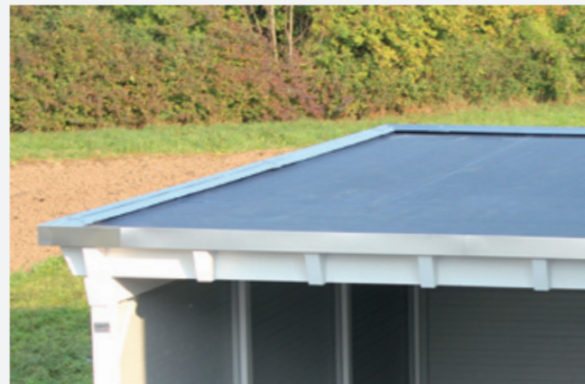
Dach aus EPDM-Membrane
