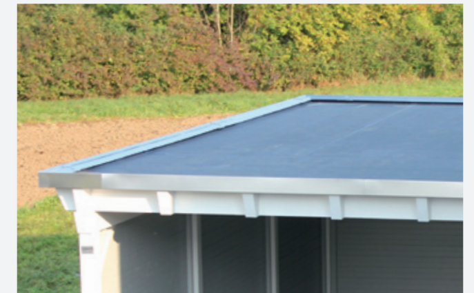
Dach aus EPDM-Membrane
