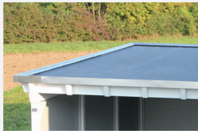
Dach-Wetterseite aus EPDM-Membrane,
