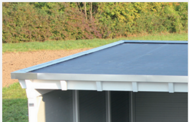
Dach-Wetterseite aus EPDM-Membrane
