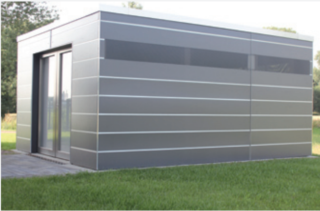
Abstellraum / Flachdach Bauhaus Trespa® Doppelte Schiebetür und Lüftungsgitter
