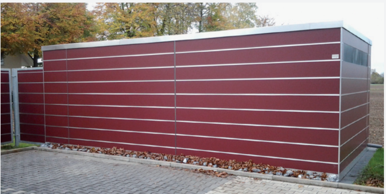
Abstellraum / Flachdach Bauhaus Trespa® Abstellraum aus einer hochwertigen Leimholzkonstruktion mit roten Trespa® Fassadenpaneelen verkleidet
