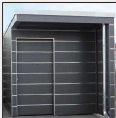
Überdach, Aluminium-Blende und Edelstahl-Feder
